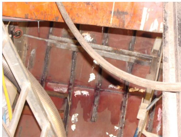
Nya plåtar monterade
